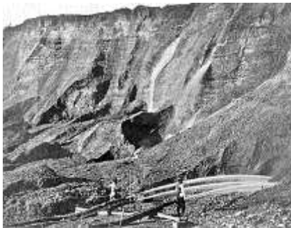
صورة ٢٢ استخدام خراطيم المياه - قوة دفع المياه - لتحطيم التربة
