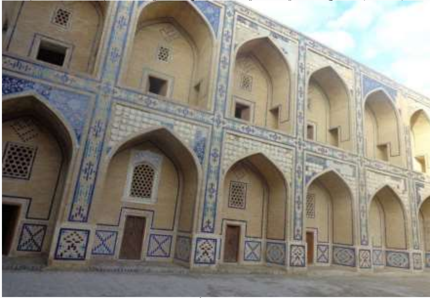
(لوحه ٧) الضلع الجنوبي الغربي بمءرسة ألع بلك فف بءارى (ءصوئر الباءء)
