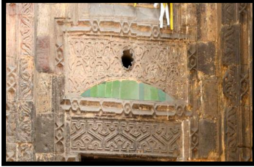
لوحة (٢٠) العتب الحجري الذي يعلو فتحة المدخل، وما يعلوه من النفيس المكسو ببلاطات من القاشاني الأخضر، يعلوه عقد عاتق، والجفت اللاعب ذو الميمات السداسية الذي يحيط بما سبق ذكره، "تصوير الباحثة".
