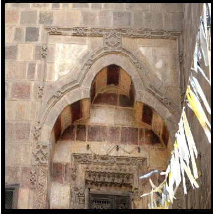
لوحة (٢٢) العقد الثلاثي المفصص المتوج لدخلة المدخل والجفت اللاعب المحيط به، "تصوير الباحثة".
