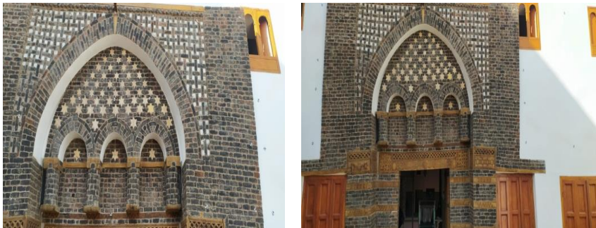
لوحة ( ٢، ١ ) منظر عام لأعمدة من الأجر بواجهة المدخل بوكالة الجداوي (تصوير الباحث )
