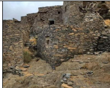
لوحة (١٨) قرية الكلادا: بيت رقم ٥٤، الواجهة الشرقية الرئيسية والواجهة الشمالية للبيت .
